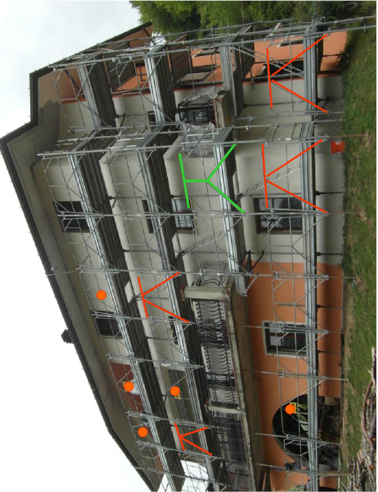
SCHEMA DI MONTAGGIO PMB 180/MP-PONTEGGIO CON TAVOLE METALLICHE AD UN NUMERO LIMITATO DI PIANI, CON PARASASSI, DI ALTEZZA UTILE mt 20
